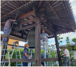
(防腐剤塗り作業)
